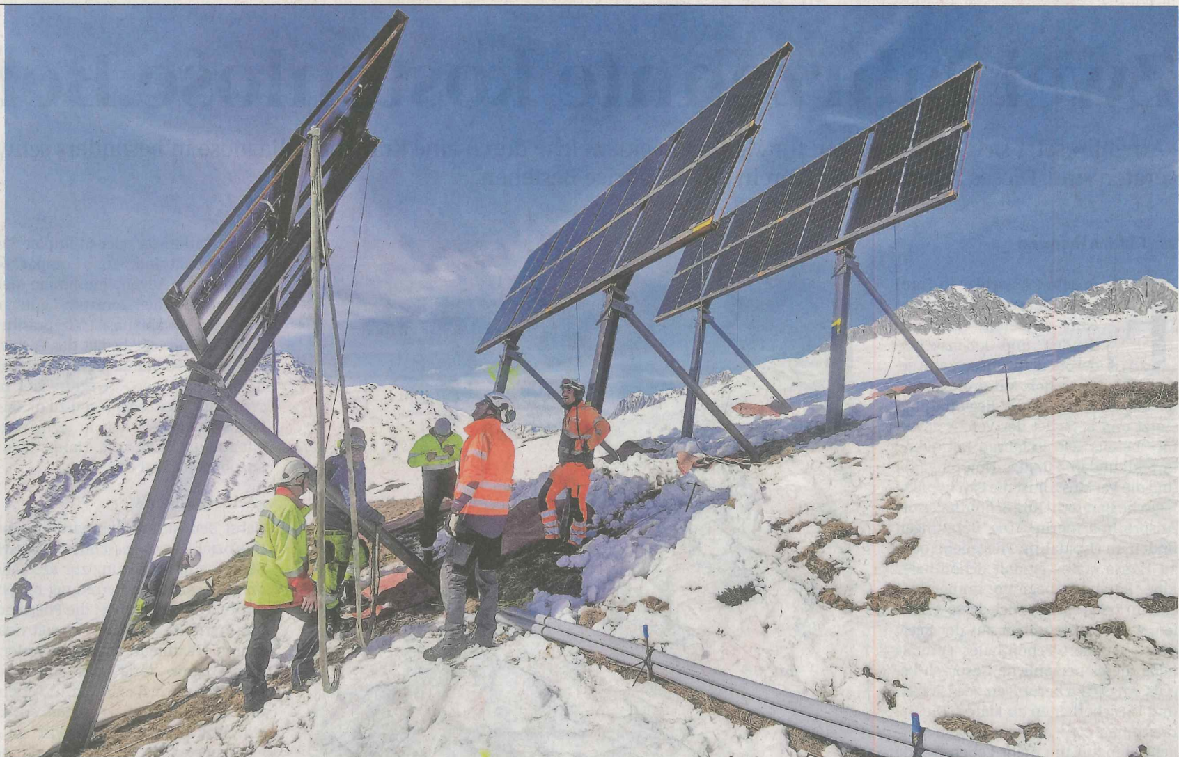
Nach der Montage: Die Testmodule von Sedrunsolar im Gebiet Scharinas-Cuolm Val sind bereit für die Versuchsphase.
